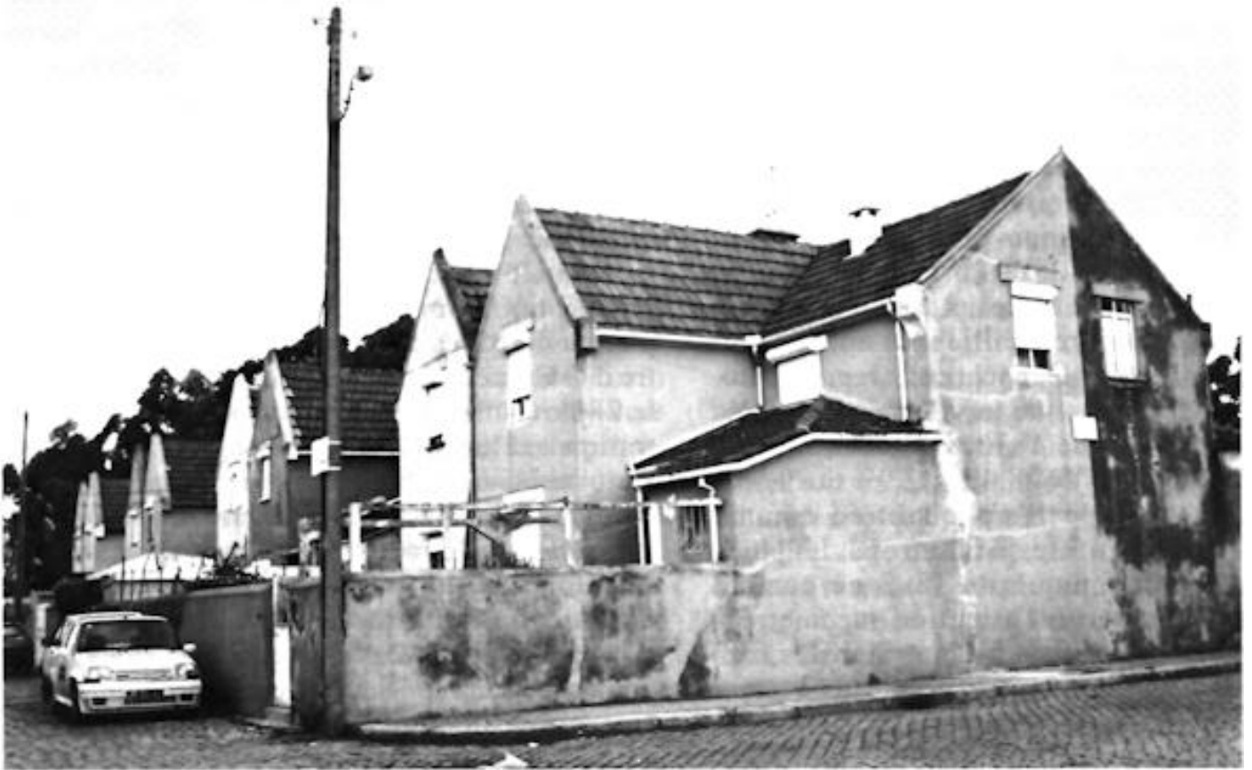
4. Des habitations groupées par quatre, de l'ancien quartier ouvrier d' O Comércio do Porto (quartier d'Antas).
